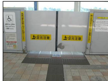
（可動安全柵扉）
