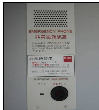
(車両連結部 非常通報装置)
